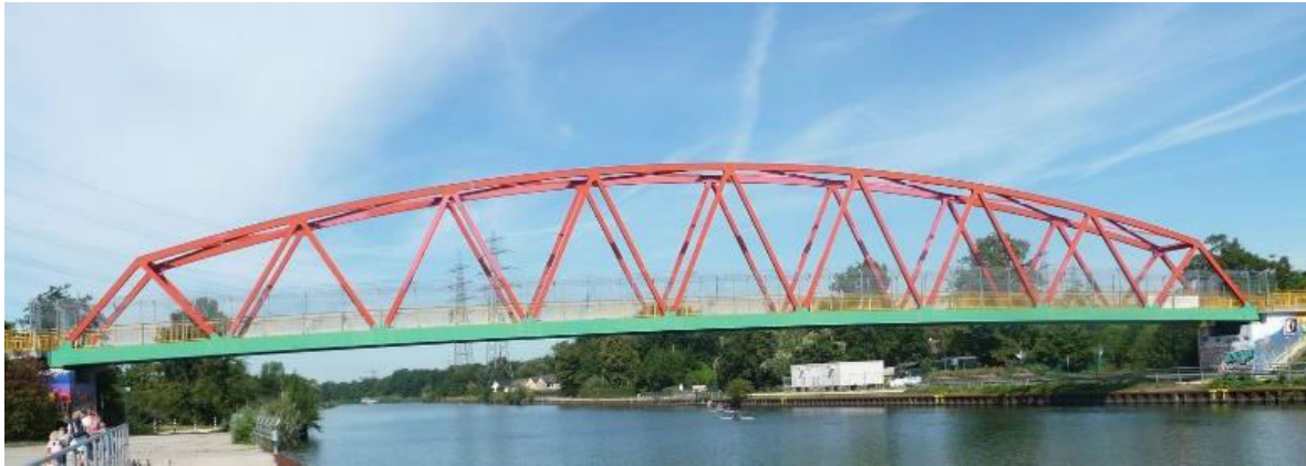
Die Papageienbrücke Zeche Fritz Unser Fritz in Herne
